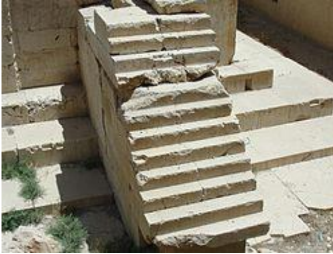
پلکان بنای کعبه زرتشت
