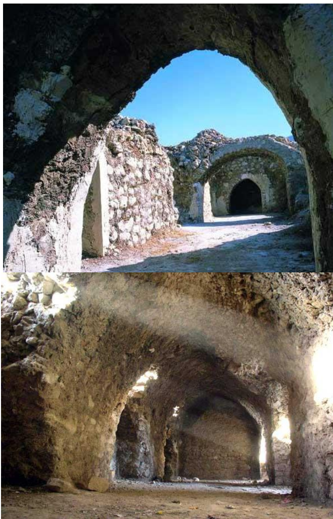
قلعه هزار در دره شهر، قلعه سپس دره شهر
