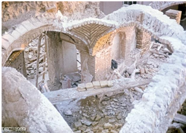
تصاویری از کاخ والی پس از تخریب
